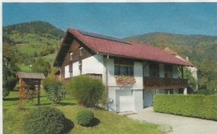
Sončna elektrarna z instalirano močjo 1,43 kWp na stanovanjski hiši družine Jelen na Ravnah na Koroškem
