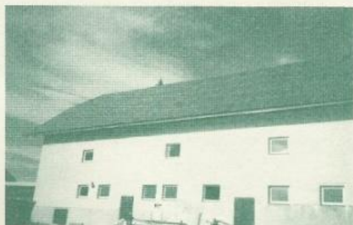
Gospodarsko poslopje z moduli za pretvarjanje sončne v električno energijo, marec 2009, foto: A. Repanšek
